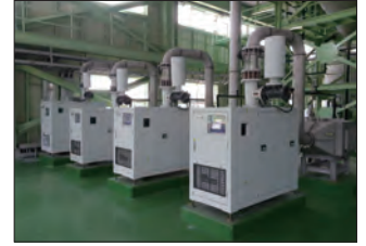
Sudokwon Landfill Site (NX150), Korea
